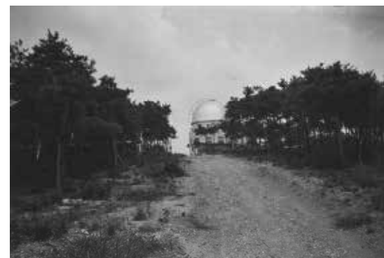
30.大ドーム完成
