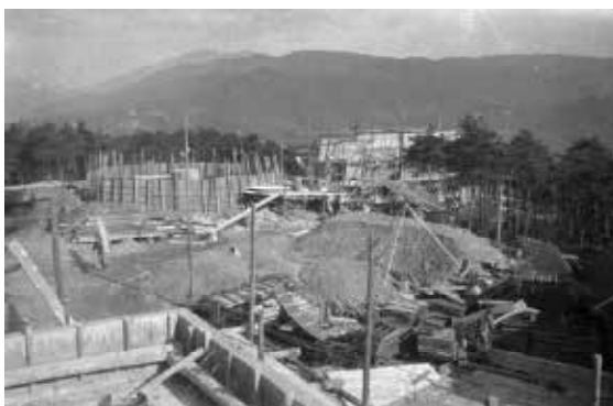
28.花山天文台建設現場
