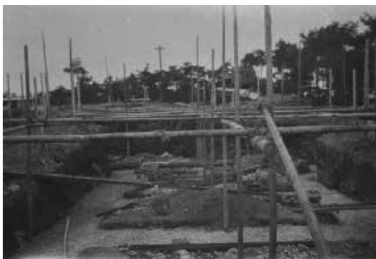
21.花山天文台建設現場
