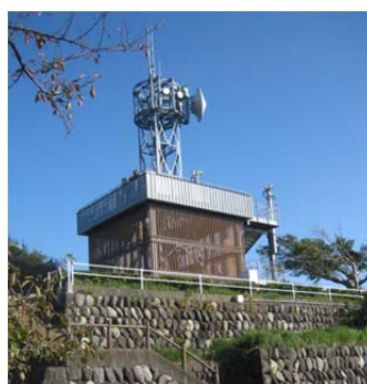
写真 10. 西側から見た石垣と跡地 アンテナの建つ展望台南側が、おそらく、ピラーの跡地(この内部にも残っていない)
