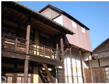
写真 5 .山本天文台観測棟
