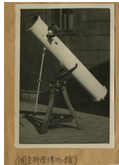
画像 7 上野の国立科学博物館に昭和 25 年納入され、現在も使用されている 20 cm 反射経緯台
