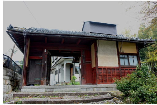
山本家の門。中間部屋の上に第一観測室がある。
