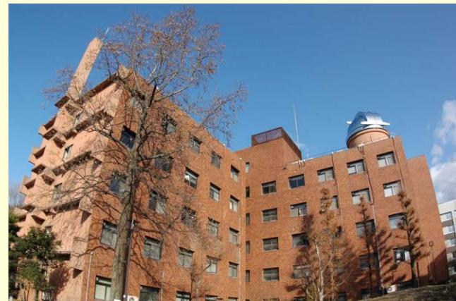
4号館屋上ドーム
