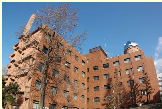
4号館屋上ドーム
