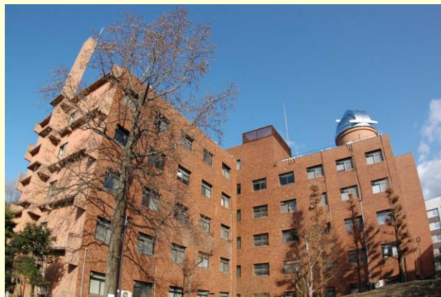
4号館屋上ドーム
